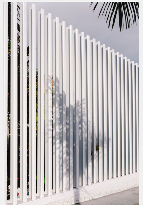
ОГРАЖДЕНИЕ ПАРКА. Пример. Индивидуальное изготовление. Металл, порошковая окраска
