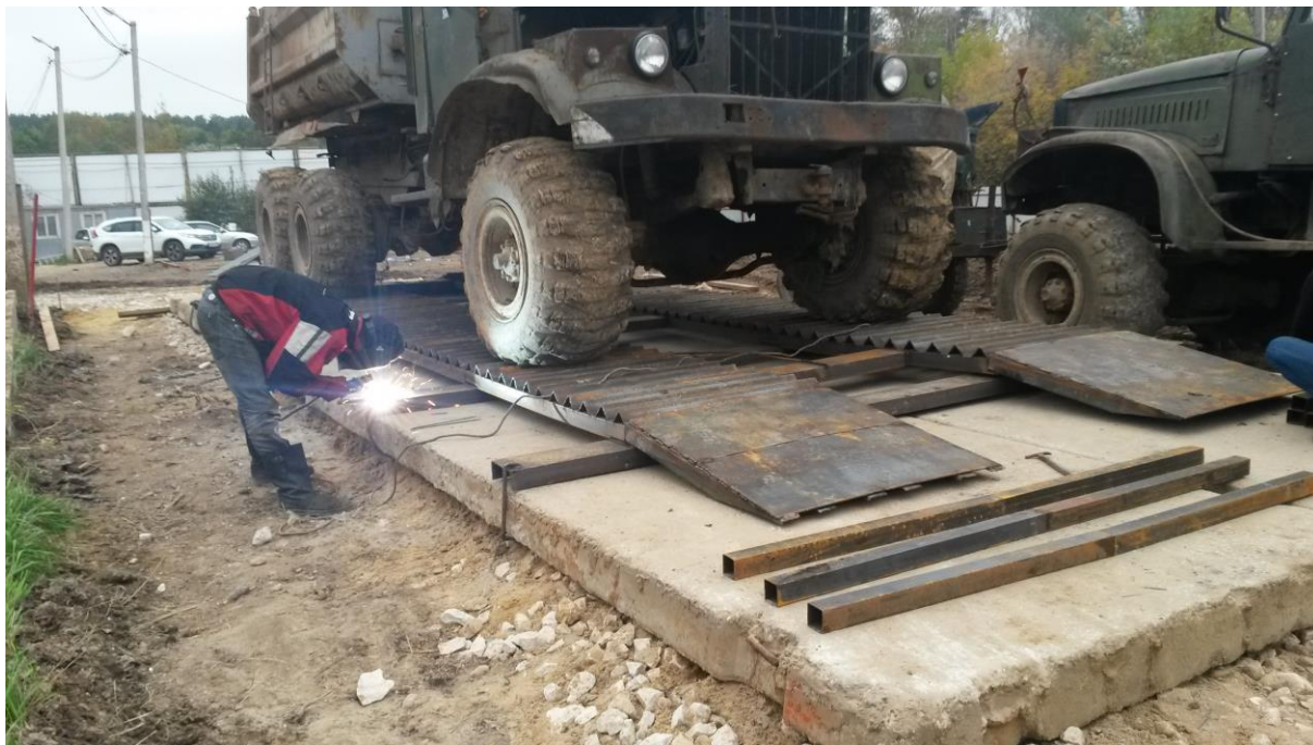
Монтаж эстакады для мойки колес.
