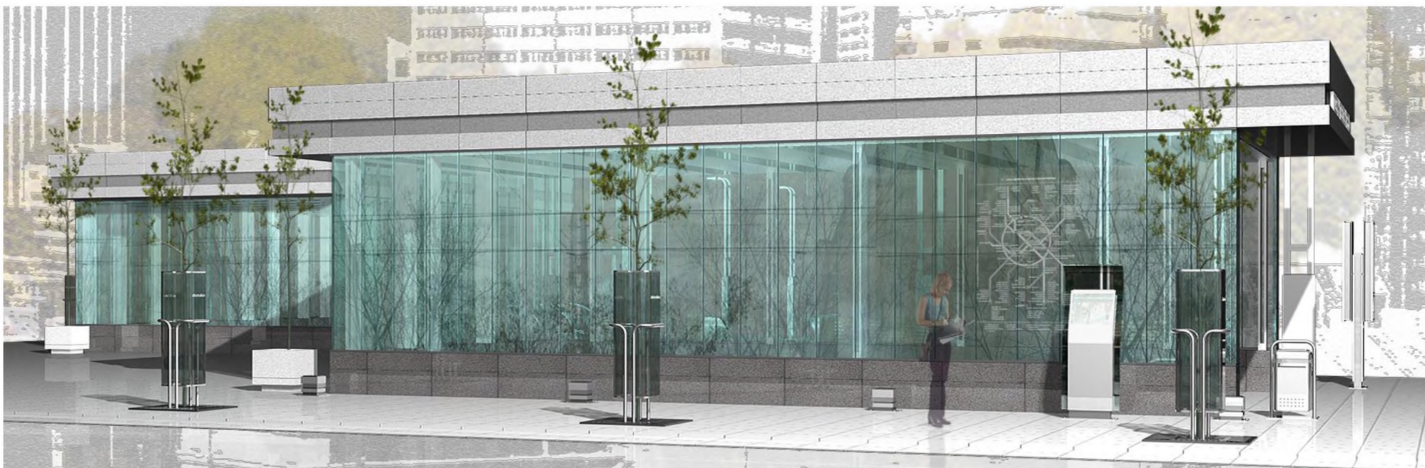
НАКРЫТИЕ ПОДЗЕМНОГО ПЕШЕХОДНОГО ПЕРЕХОДА
